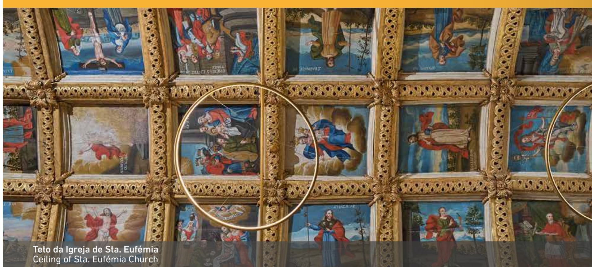
Teto da Igreja de Sta. Eufémia Ceiling of Sta. Eufémia Church
